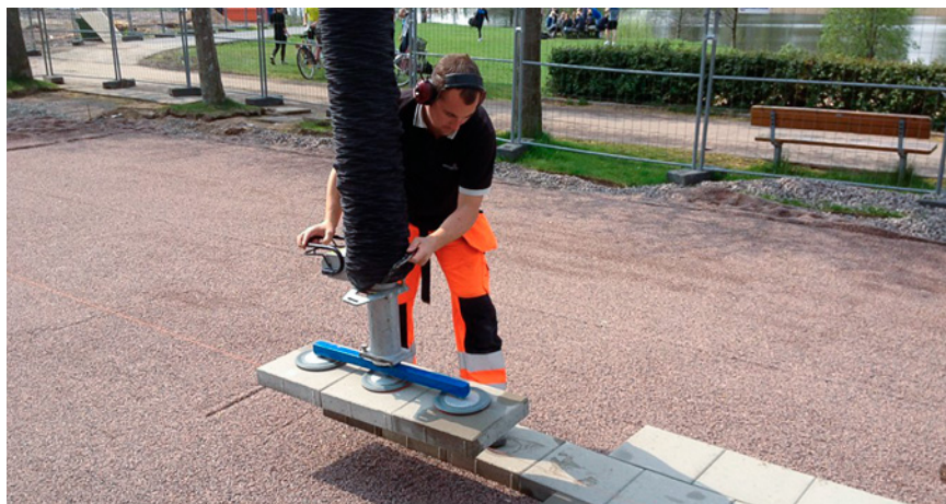
Läggmaskin med vakuumsug.
